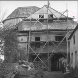
Oprava domu č. 1226 dnes muzea 1960.
