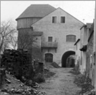
Oprava domu č. 1226 dnes muzea 1960.
